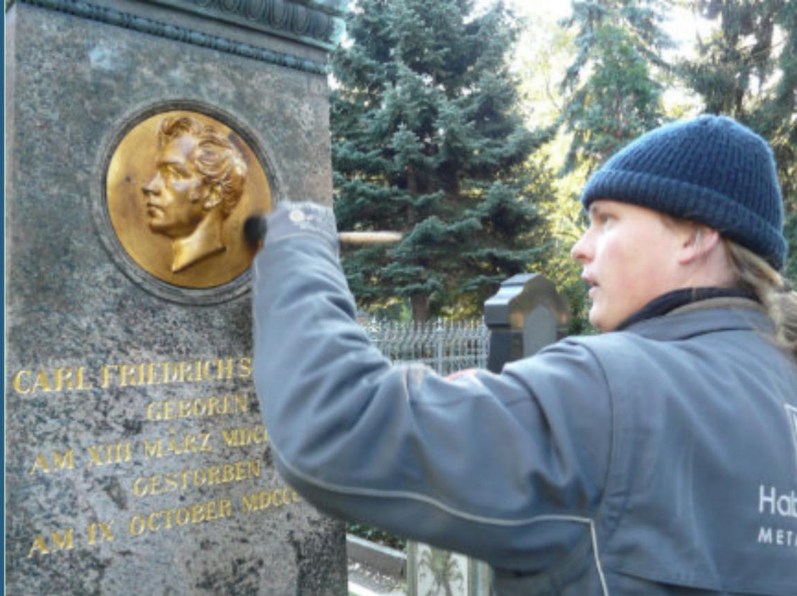
Abb. 45: Reinigung des Porträt-Medaillons durch Herrn Behr. Hier wurden typische Zinkausblühungen (weiße Kügelchen) entdeckt. Es konnte nicht festgestellt werden, wann das Zinkporträt angebracht wurde. Möglicherweise erfolgte hierbei auch die Vergoldung, die nicht ursprünglich ist.
