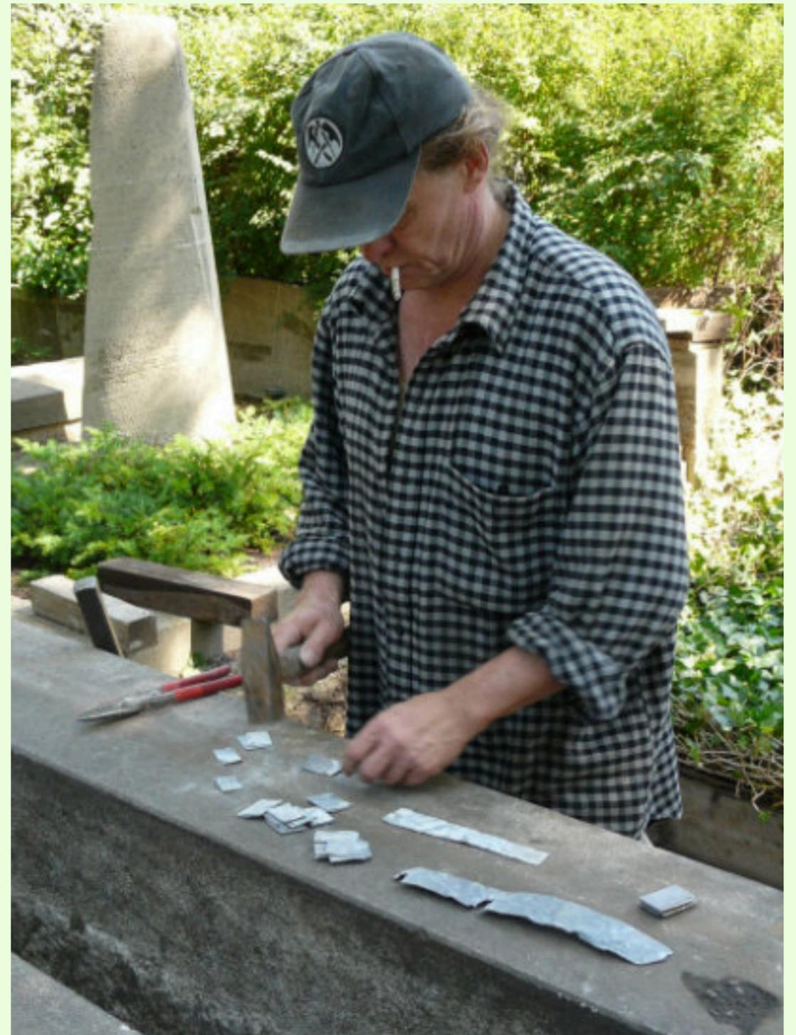
Abb. 57: Vorbereitung der Feinnivellierung der Einfassung mit Zinnplättchen
