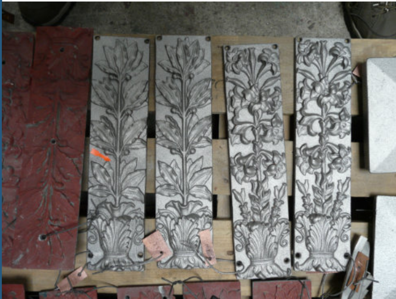
Abb. 21: Die Zink-Ornamentplatten der Zaunpfosten mit allegorischen Pflanzenmotiven und Altfarbenbefund
