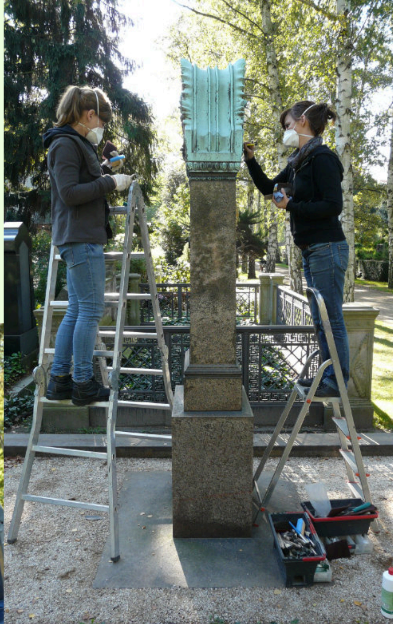
Abb. 43 und 44: Säuberung/Reinigung des Bronzeakroterions bis auf die natürliche Oxidationsschicht mit feinem „Besteck“
