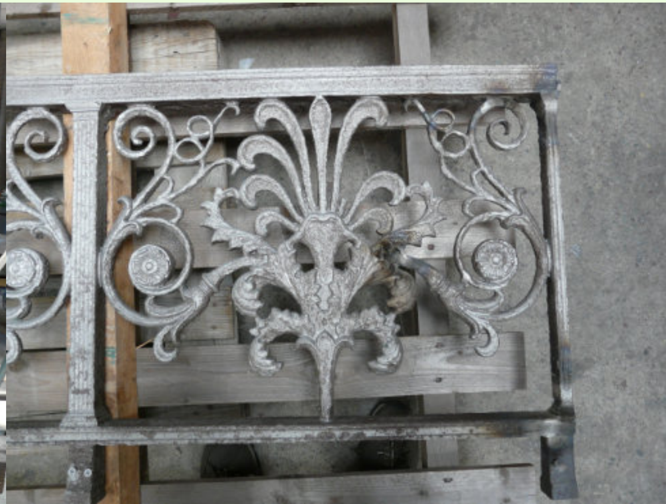
Abb. 19: Werkstattbesuch - Ergänzung von Fehlstellen (nach Schinkelschem Fabrikantenentwurf)
