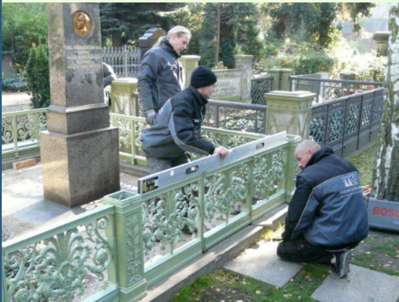
Abb. 81: Montage des letzten Zaunelements mit der Zugangstür (17.10.2011)
