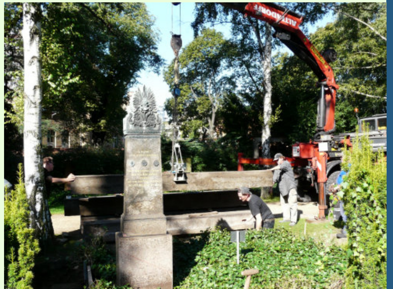
Abb. 54: Demontage der monolithischen Granitsockel
