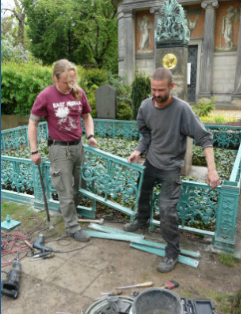
Abb. 12: Nach der Durchpositionierung aller Zaunteile erfolgt die Demontage der ersten Zaunfelder und die Auffindung des ursprünglichen Torflügels mit Türbandresten
