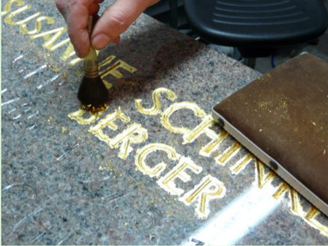
Abb. 62: Aufbringen des Blattgoldes mit Spezialkleber
