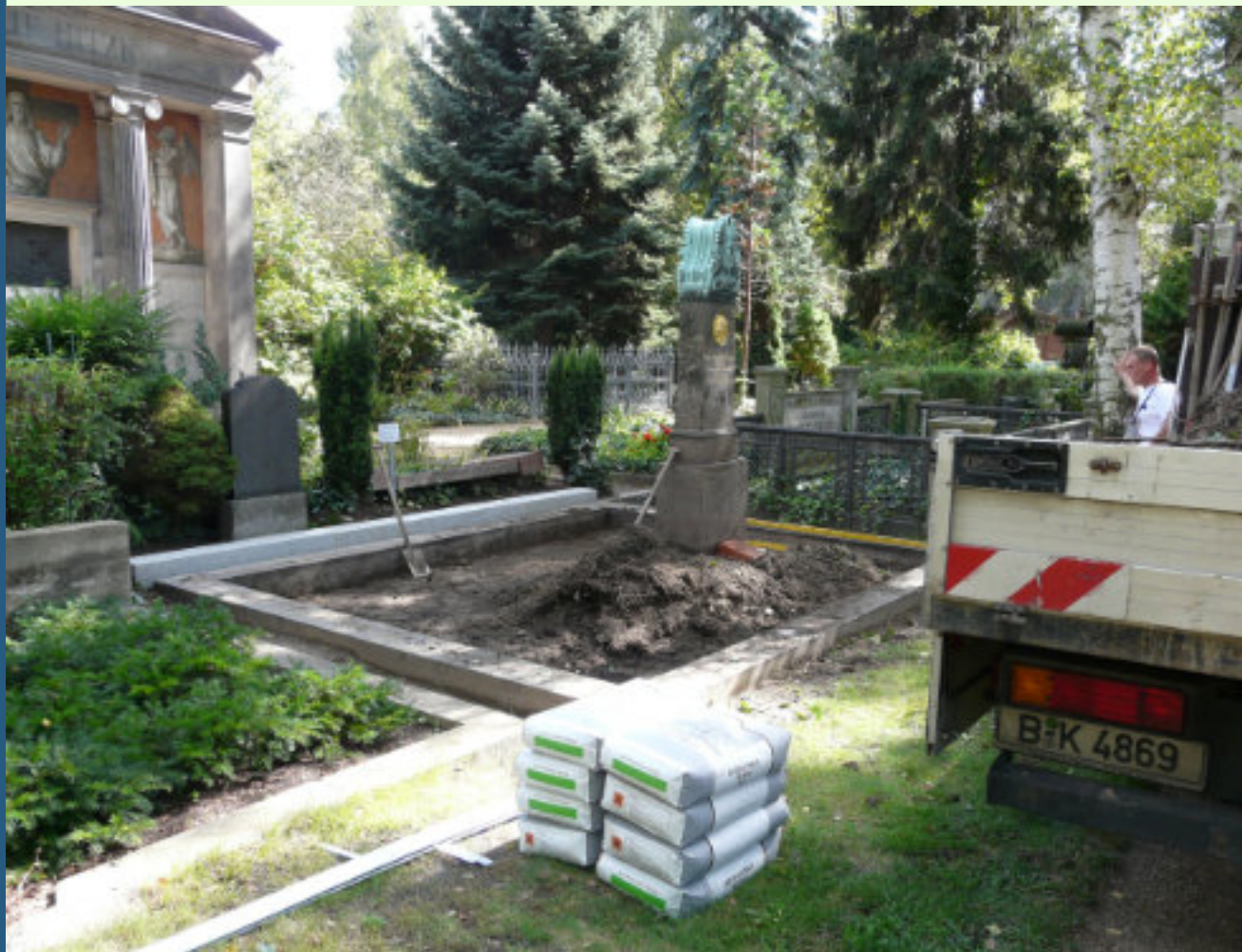
Abb. 76, 77 und 78: Erdarbeiten mit Erdaushub für die Neugestaltung der Grabfläche mit Efeubewuchs
