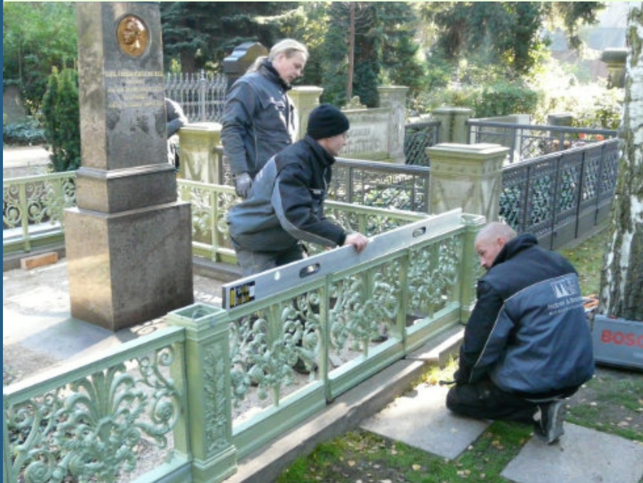
Abb. 81: Montage des letzten Zaunelements mit der Zugangstür (17.10.2011)
