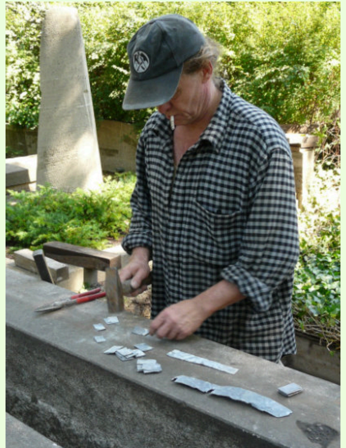
Abb. 57: Vorbereitung der Feinnivellierung der Einfassung mit Zinnplättchen
