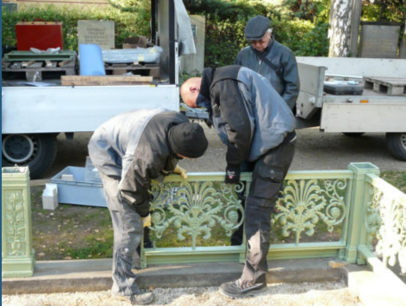
Abb. 80: Montage nach Positionsplan mit Stiftung und Schrauben aus Edelstahl
