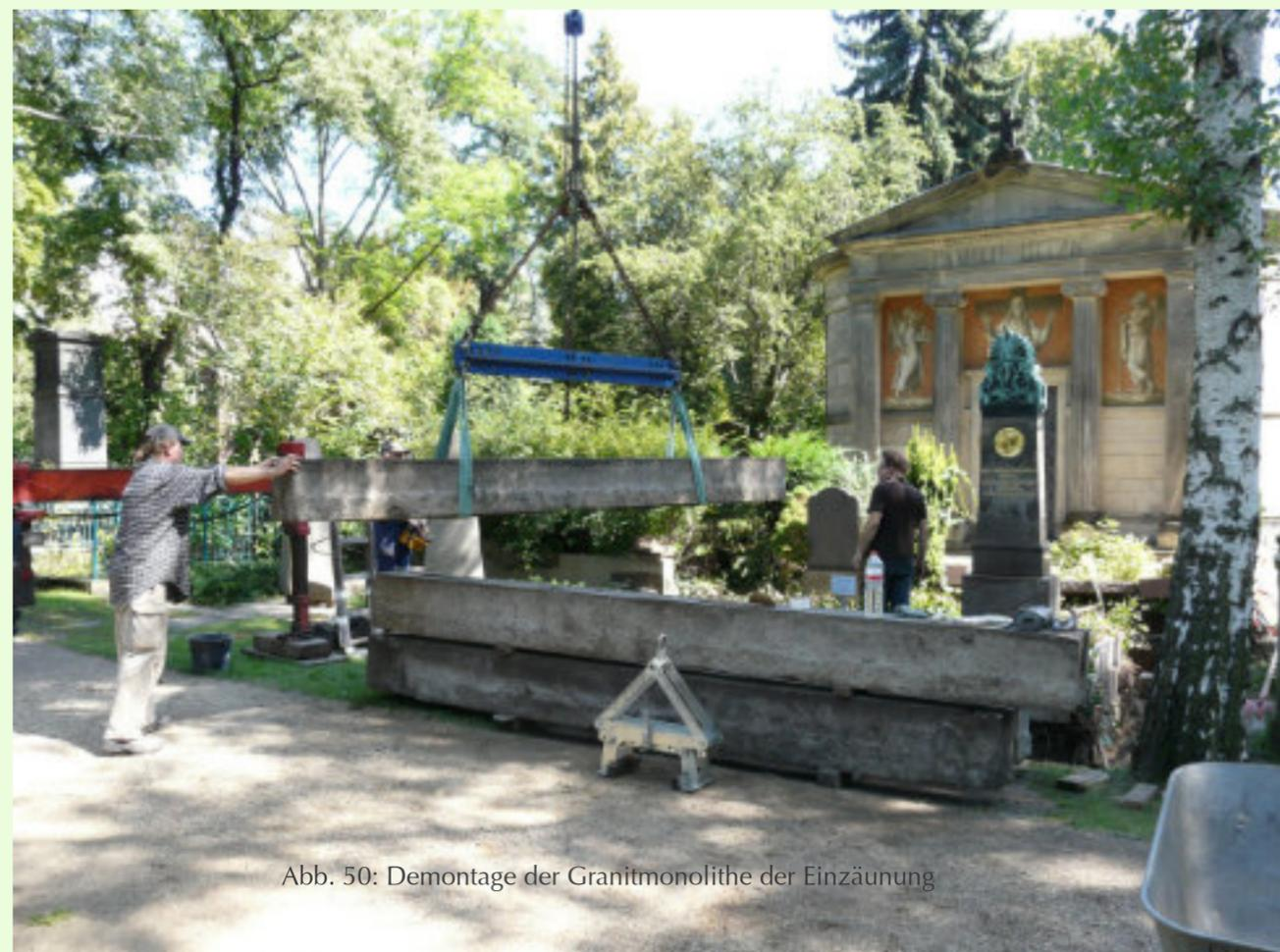
Abb. 50: Demontage der Granitmonolithe der Einzäunung
